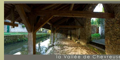
la Vallée de Chevreuse Lavoir de Chevreuse
